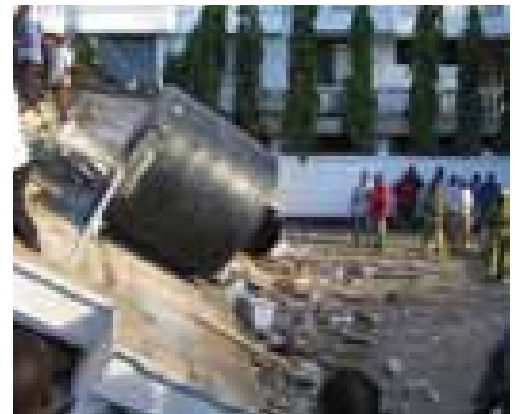
Der große Kunststoffwasser-tank wird vom Dach geworfen
