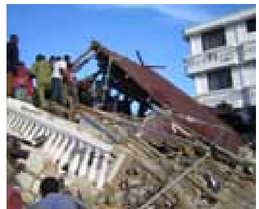
Mit Händen und Dachlatten wird das Dach hochgehoben und runtergeworfen
