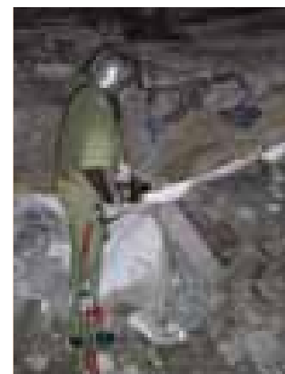
Mit der Schere wird die Armierung durchtrennt
